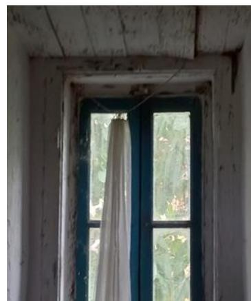
*Figura 3 – Teto com fissuras e caixilharia degradada*
