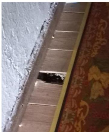
*Figura 2 – Pavimento degradado*
